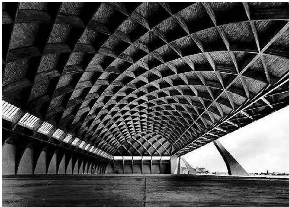
加肋混凝土壳飞机库
